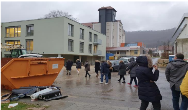
Baustellenführung im neuen Pflegeheim
